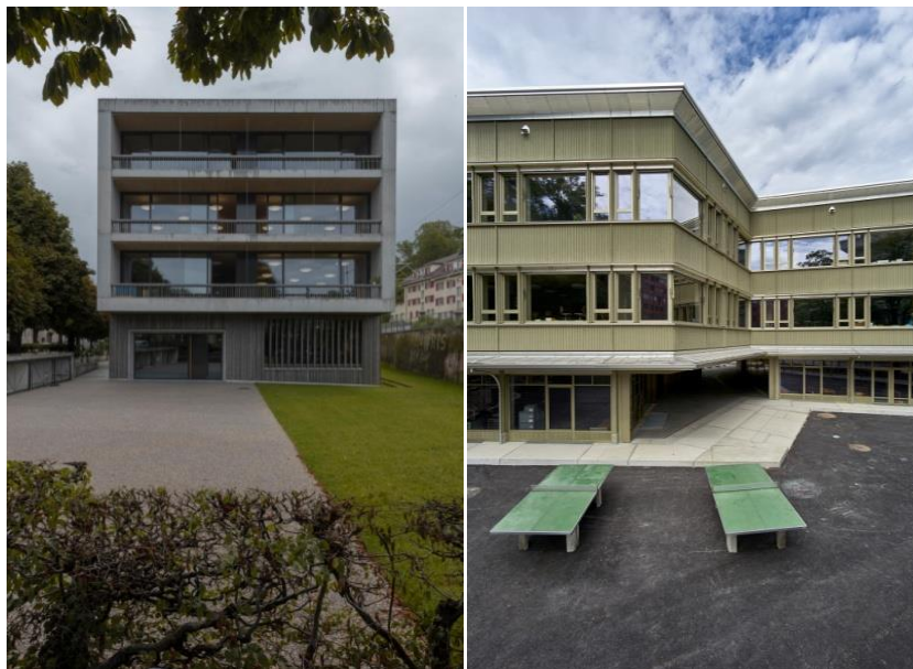
Die neu gebauten Schulhäuser Pestalozzi II und der Erweiterungsneubau Volksschule Marzili (Bilder: Marco Raho und Thomas Kaspar)
